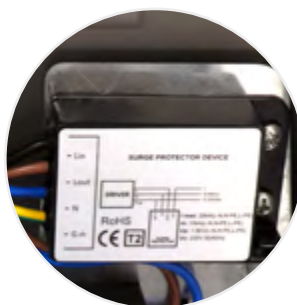
Protector de sobretensiones 20 kV
