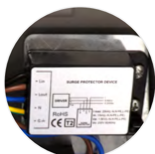
Protector de sobretensiones 20 kV
